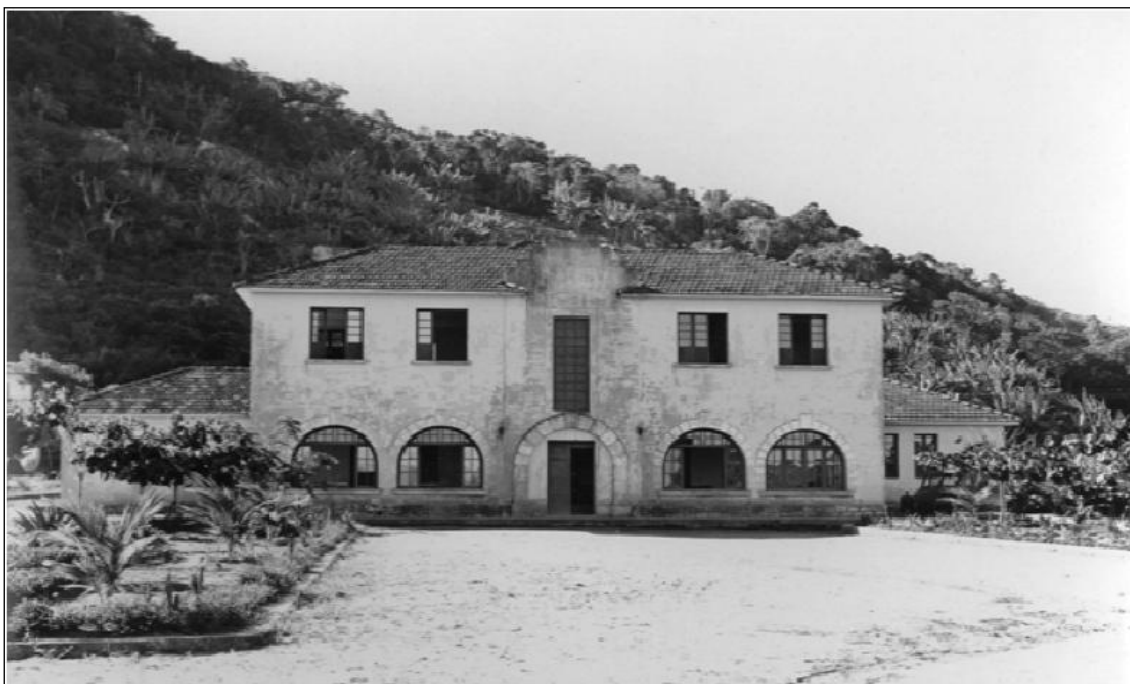
Figura 5 - Preventório Gustavo Capanema situado na Praia da Costa, Vila Velha.
