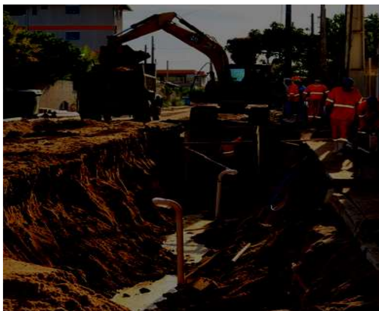
Figura 12 – Realização de obras de infraestrutura básica da localidade de Marobá, contendo, implantação das redes de distribuição de água potável, de captação do esgoto doméstico e de drenagem pluvial
