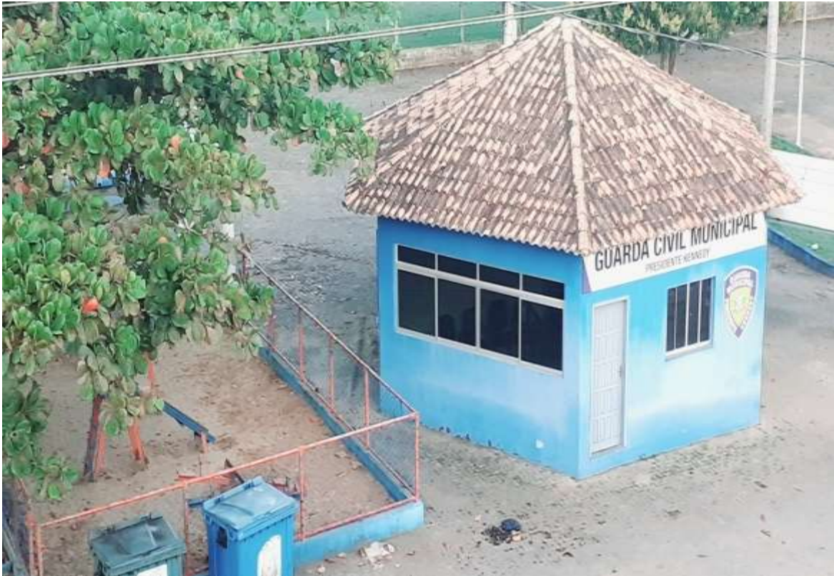
Figura 4 - Unidade da Guarda Civil Municipal desativada
