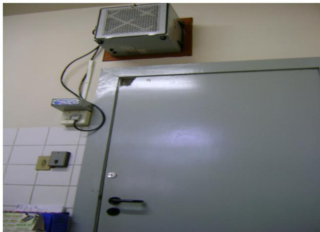
**Figura 33: Detalhe da porta de entrada da sala de atendimento do PCT mostrando o filtro que leva o ar para o corredor e a abertura no alto. CRA da Serra-ES.**
