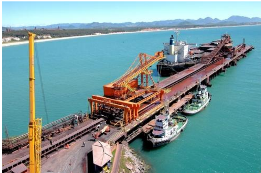
Pier , 313 metros de comprimento por 22 metros de largura e 2 berços de atracação protegidos por um quebra-mar em -L-, o Terminal Marítimo de Ponta Ubu é um dos maiores do país. Fonte: Milton Brigolini Neme/panoramio
