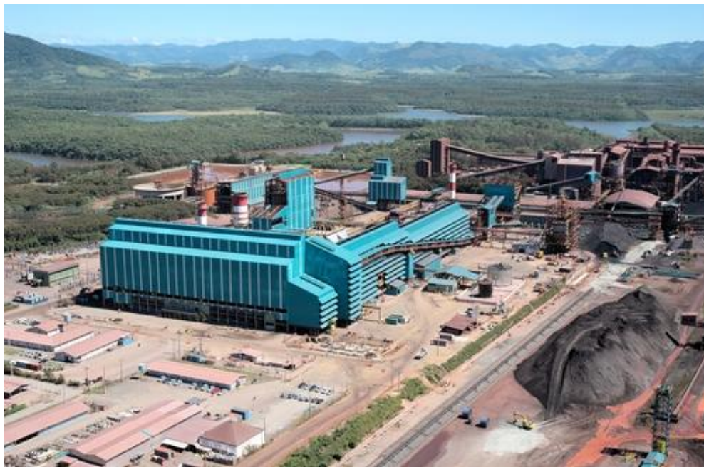
Terceira Usina de Pelotização da Samarco Mineração na unidade industrial de Ponta Ubu ES. Processando 23,5 milhões de toneladas de minério. exportadoras do mercado transoceânico Fonte: Milton Brigolini Neme/panoramio
