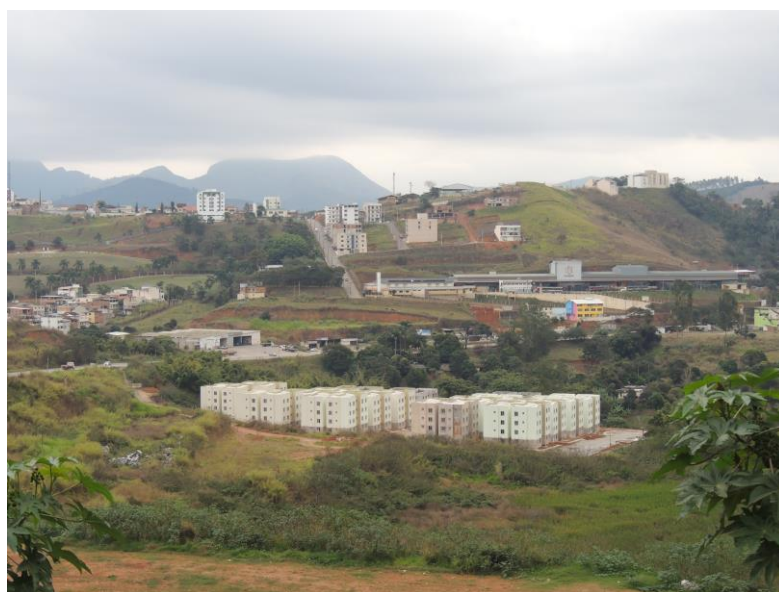
Figura 2. Visada para cidade de Manhuaçu/MG -Residencial Clube do Sol PMCMV
