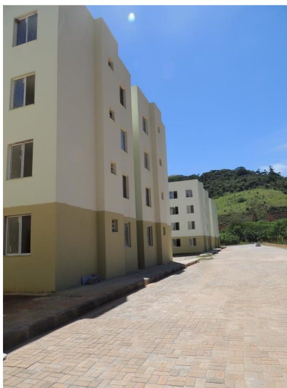
Figura 8. Conjunto Habitacional Residencial Clube do Sol: Moradia e pavimentação
