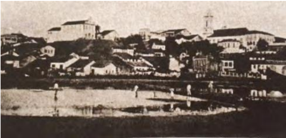
Figura 7 – Foto da região alagada do Campinho
