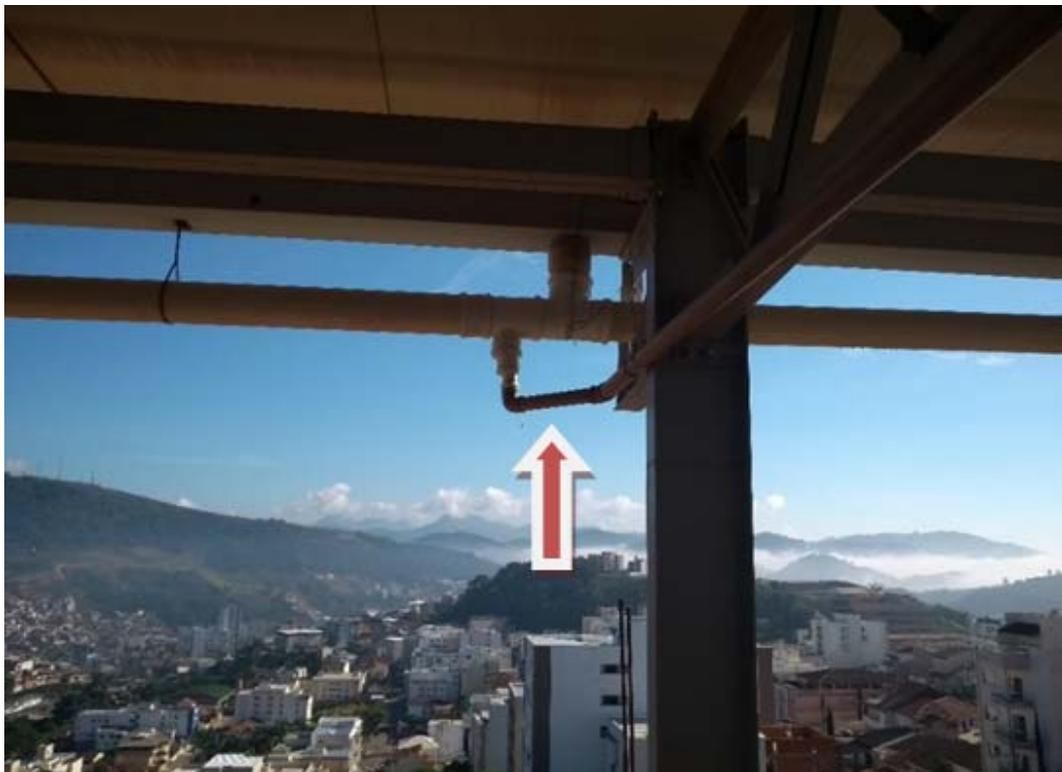
**Figura 11-** Um dos pontos de captação da água da chuva
