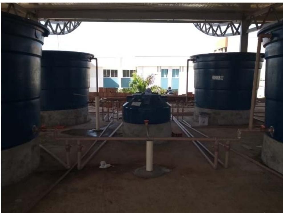
**Figura 17-** Sistema de barrilete instalado
